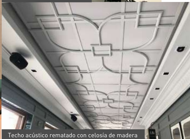
Actuación en techo y paredes
