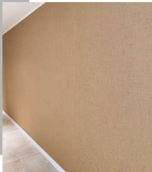
Pared de material acústico forrado con yute
